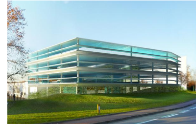
silo à véhicules du centre technique
